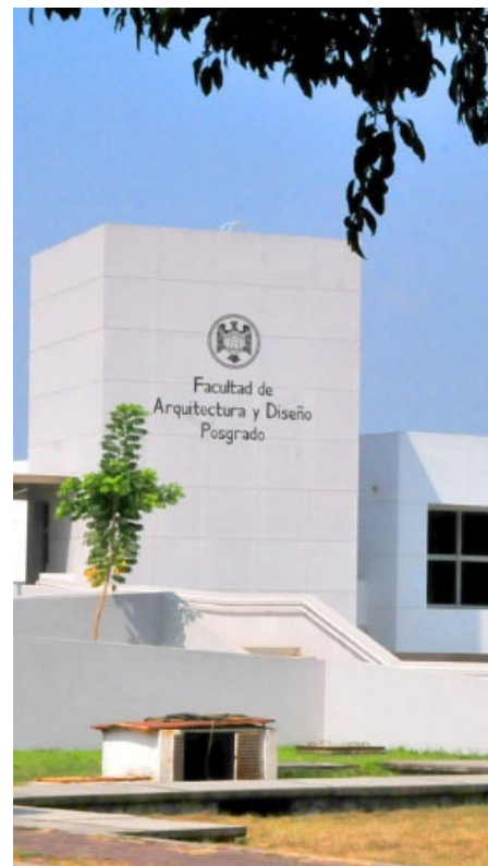
Fachada del edificio
