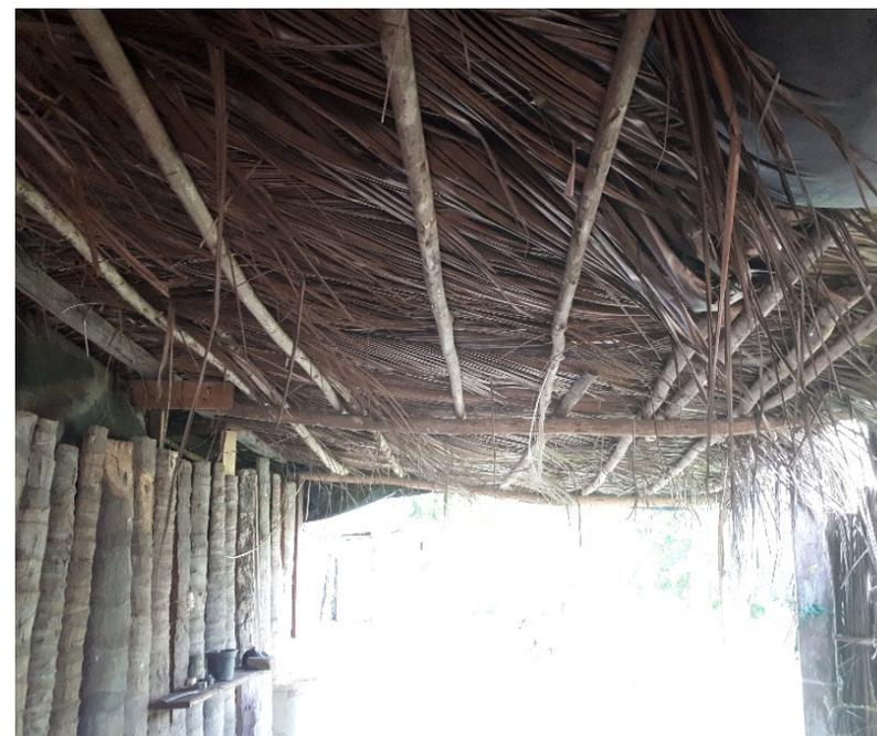
Figure 8. Estructura de capote y cubierta de palapa.
